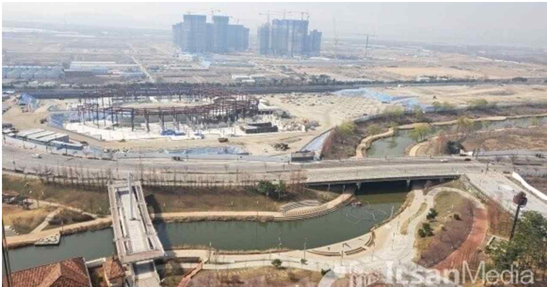
<그림 2-3> 공사 중단 후 방치되고 있는 K-팝 아레나 현장
